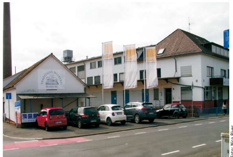
▲ Vor der ehemaligen Molkerei in der Frauenbergstraße wehen bereits die Fahnen des Investors S+S.
