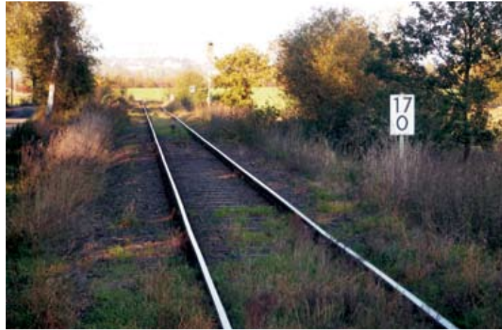
▲ Schienen der Ohmtalbahn zwischen Kirchhain und Schweinsberg
