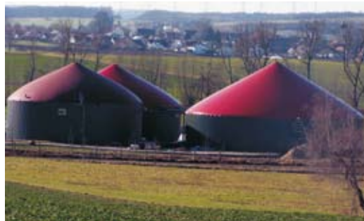
▲ Biogasanlage der Gesamtschule Heskem
