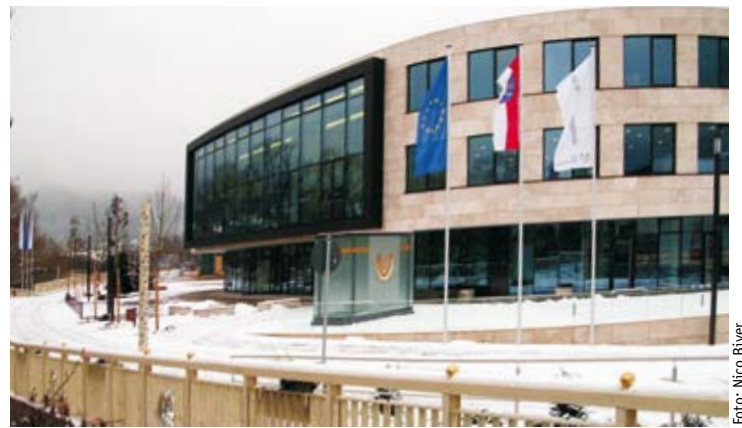
▲ DVAG-Verwaltungsgebäude an der „Anneliese Pohl Allee“
